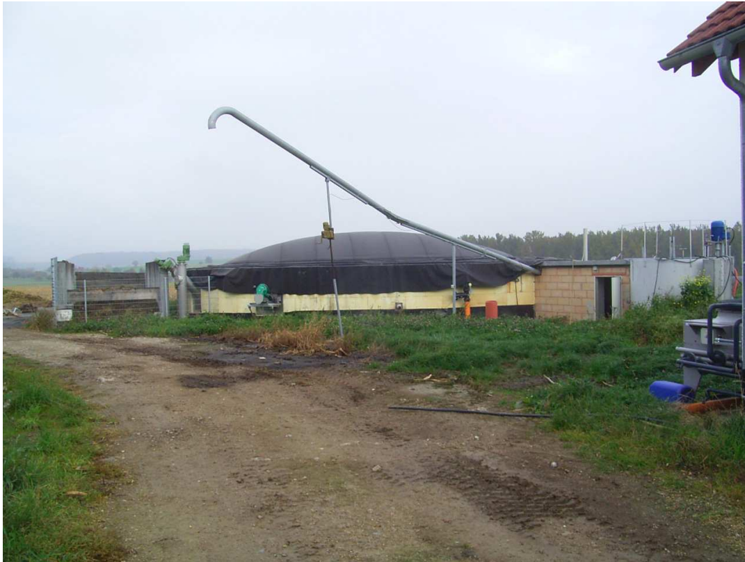
Biogasanlage auf dem Martinshof
