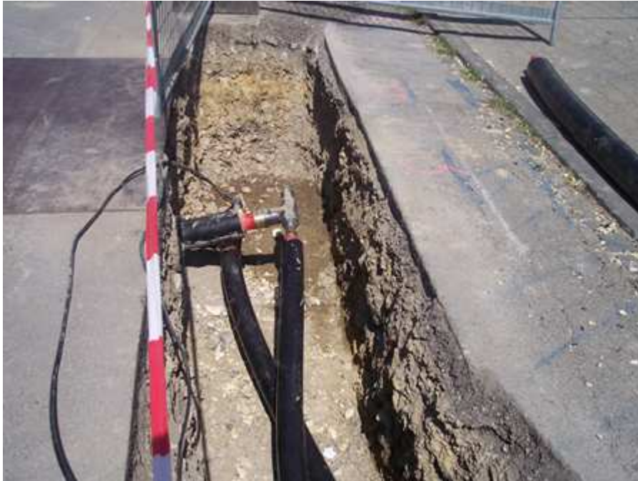
Nahwärmeleitung mit T-Stück im offenen Graben
